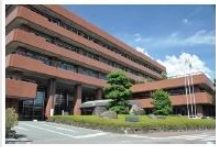
市役所や消防署など 公共施設
